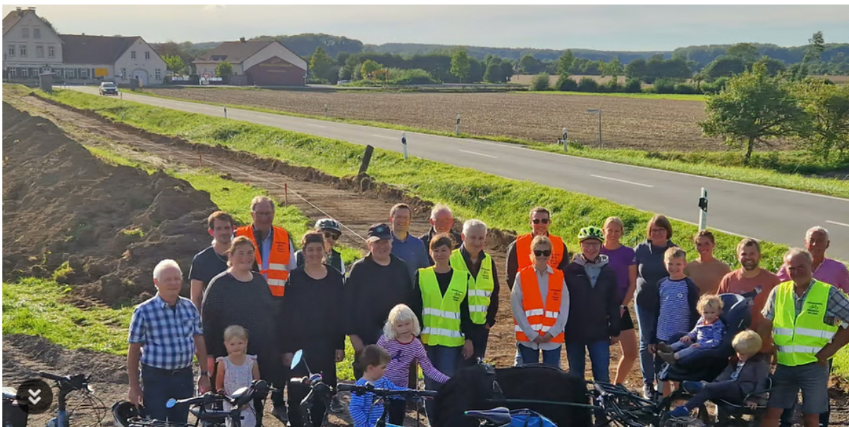
Endlich sind die Bauarbeiten am ersten Bürgerradweg in Havixbeck an der L874 gestartet: Die Mitglieder des Vereins „Bürgerradweg Hangsbeck-Walingen“ sind nach Jahren der Planung natürlich froh und stolz zugleich. Foto: Rabea Wortmann
