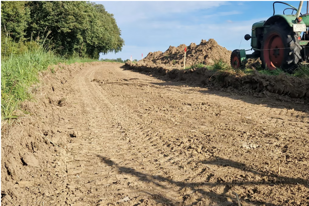
Der Bodenaushub für den ersten Abschnitt des Bürgerradwegs an der L874 in Havixbeck hat begonnen: In Kürze soll die Asphaltsschicht aufgetragen werden, sodass die Freigabe noch dieses Jahr erfolgen könnte. Foto: Rabea Wortmann
